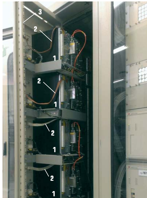
▲ Рис. 2. Устройство заземления МУРЗ с использованием эквипотенциальной поверхности. 1 – МУРЗ в металлических корпусах; 2 – заземляющие медные шинки; 3 – элемент конструкции металлического шкафа, выполняющего роль эквипотенциальной поверхности
