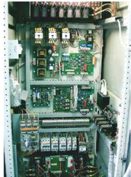
Рис. 1. Устройство зарядно-подзарядного агрегата типа SCR45A60V
